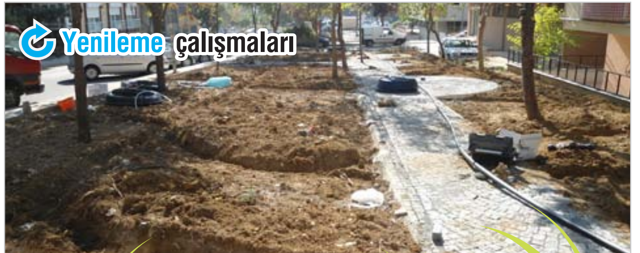
➤ Kısıklı Mh. Prestij Havuz yapımı
