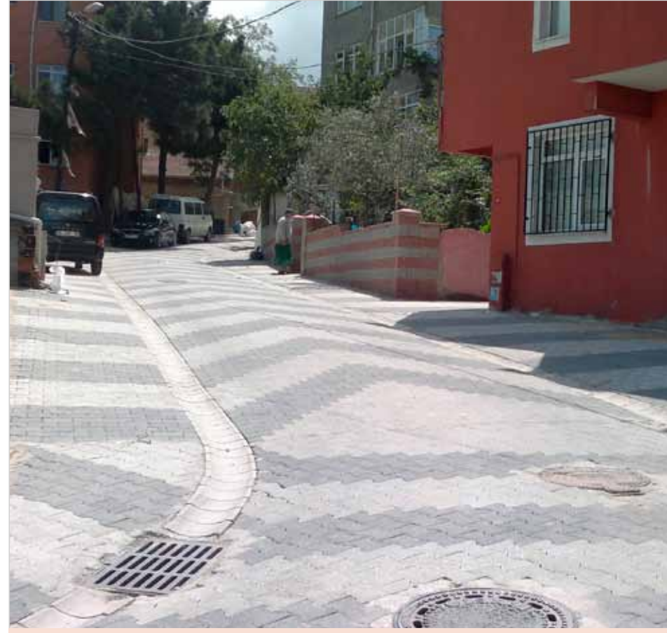
Kibar Sokak Taş parke yol
