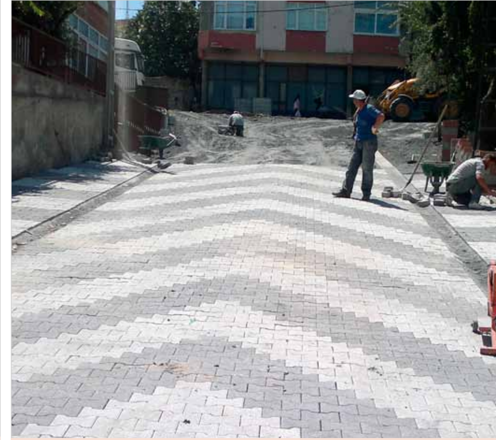
Nergis Sokak parke yol
