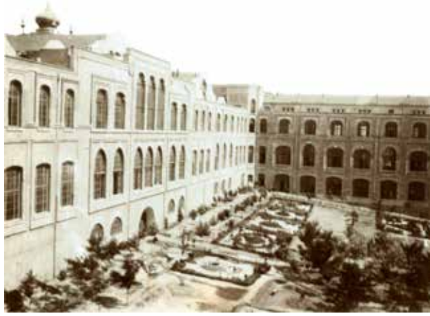
Resim 11: Mekteb-i Tıbbiye-i Şahane hastanesinin umumi manzarası (İ.Ü. Nadir Eserler Ktp. 90558/8) Altı yıl sonra şubesi olduğu Darülfünun Tıp Fakültesi de hastane binası olarak kullanılmıştır.
