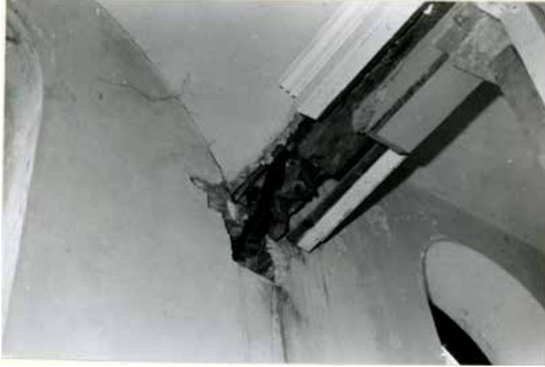
Resim 18: Köşk içi kirişlerin çürük durumu (1989)
