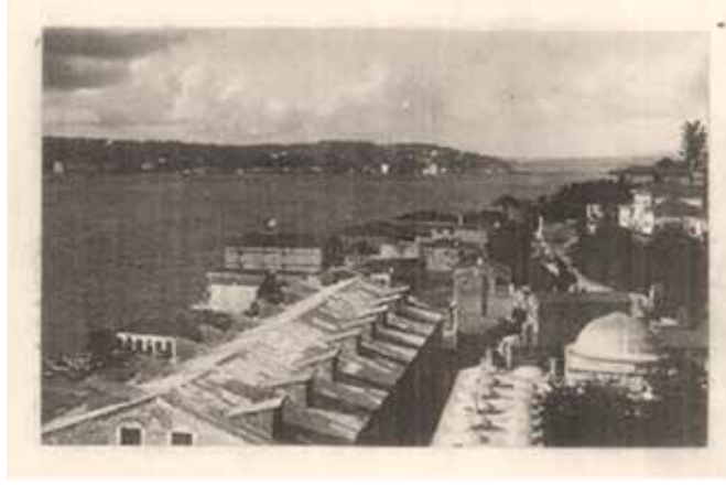
Şekil 12: Mihrimah Sultan Külliyesi içindeki kervansaray yapısını gösteren fotoğraf (Kudeb arşivi)
