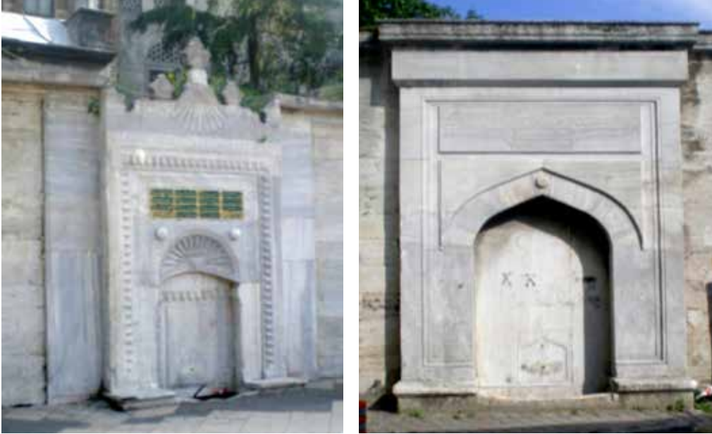
Resim 2: Yeni Valide Külliyesi yanındaki çeşmeler
