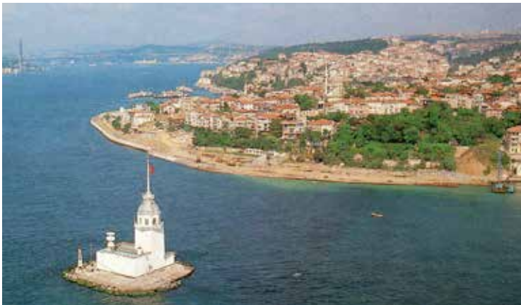
R69: Üsküdar-Salacak-Harem arasında uzanacak olan yeni sahiyolu (halk arasındaki şekliyle kazıklı yol) inşaatı hazırlıkları. Denizin doldurulması ameliyesi hemen hemen tamamlanmış, sıra yolun terazisinin dengelenmesi çalışmalarına gelmiş. Önceleri sahille içiçe olan evler, artık bundan böyle Kızkulesi'ni ve karşı yakayı yirmi-yirmibeş metre geriden seyredecekler... Buna da râzı olmak lâzım, hemen önünüzde size doğru bakıp göz kırpan bir bibloya, Kızkulesi'ne muvâzi bir balkona sahip olmak çok az İstanbulluya nasip çünkü... (Kartpostal)
