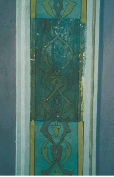
Duvarlardaki dar uzun panodaki kalem işlerinden örnek
