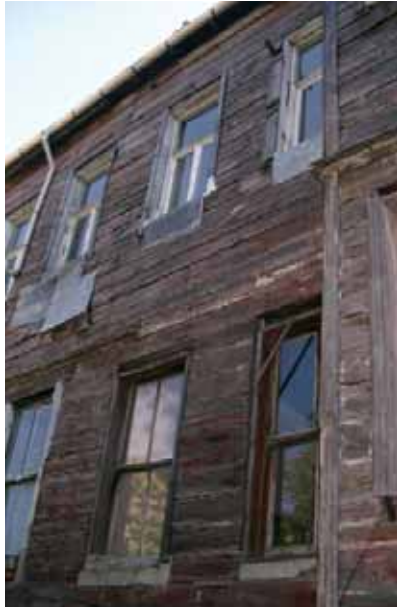
Şekil 34. Kuzeydoğu Cephesi Doğu Yönü
