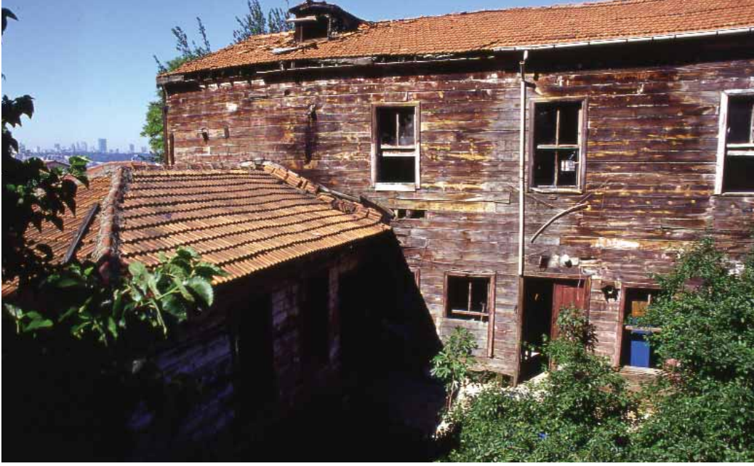
Şekil 36. Güney Cephesi Genel Görünümü
