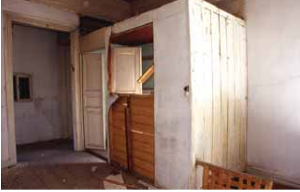
Şekil 22. 201 Mekanında Mutfak Olarak Kullanılmak Üzere Ayrılmış Kısım
