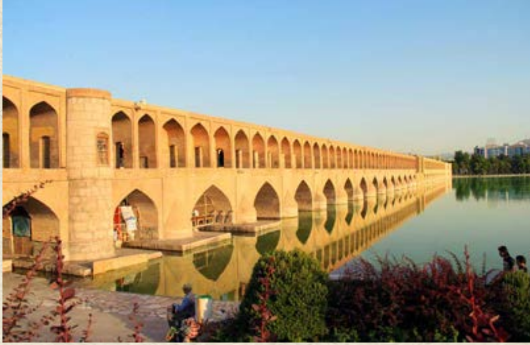
Nehir manzaralı Hacı Köprüsü Medresesi - Şah Abbas (1557 - 1628) döneminde veziri Lütü Alihan Hacı tarafından yaptırıldı
