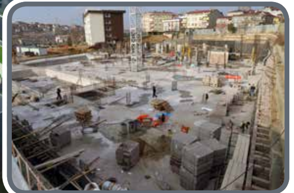
Ünalán Bilim Merkezi Gözlem Evi ve Yaşam Merkezi (Hafriyat Çalışması)
