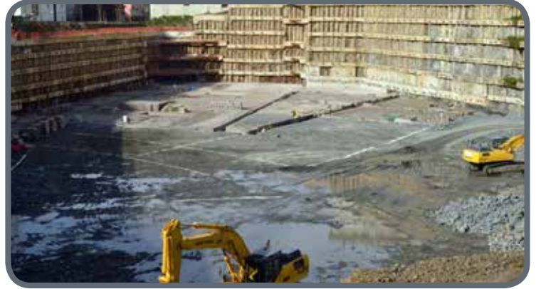
Üsküdar Bld Kongre Mrk, Şehir Otoparkı, Belediye Binası ve Kapalı Spor Salonu Hafariyat Çalışması
