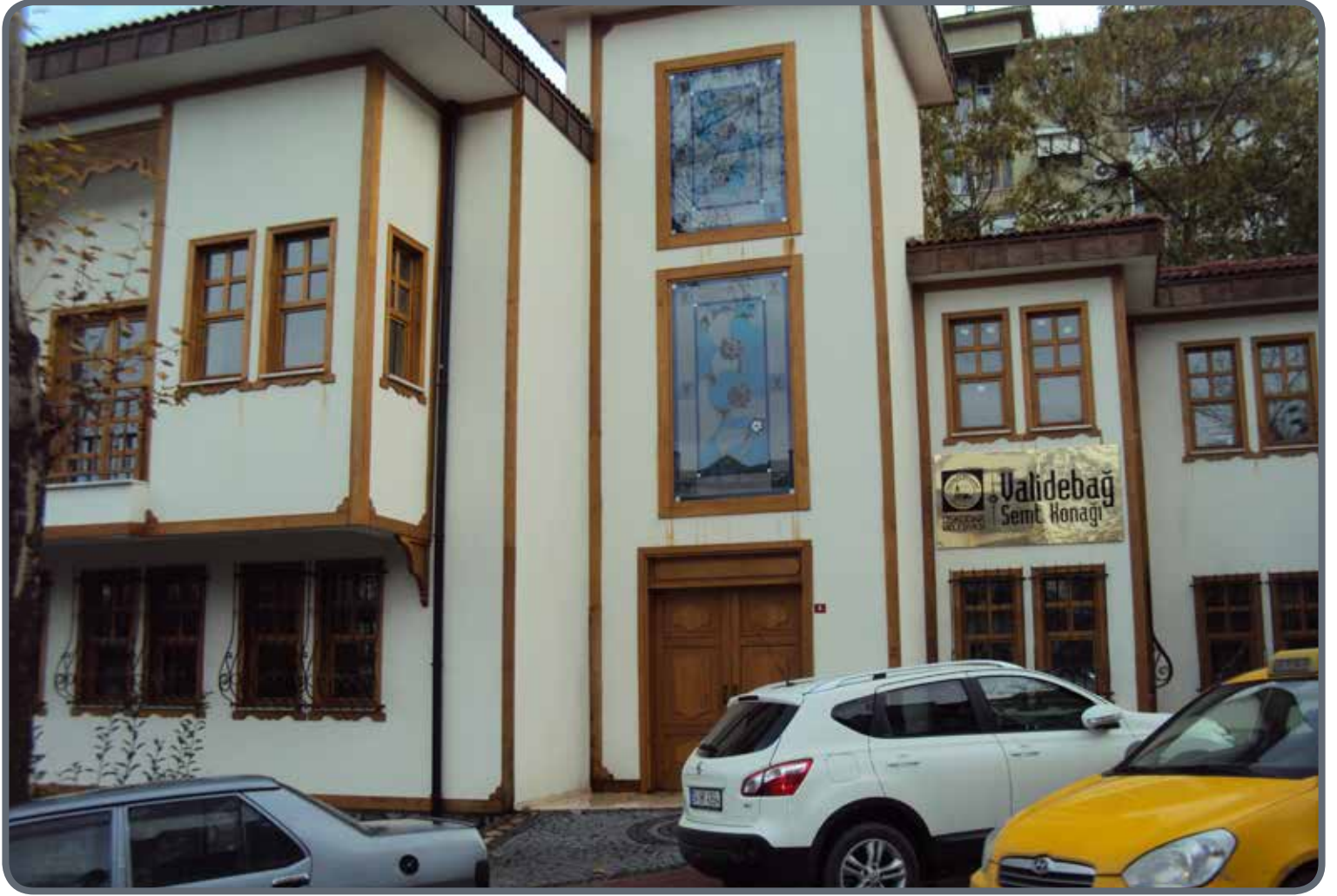
Ek - 39-40: Validebağ Semt Konağı Kapı ve Saçak Düzenlemesi (önce)
