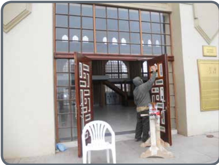
Ek – 40-41-42-43-44-45: Bağlarbaşı Kültür Merkezi- Ahşap Yapı Elemanlarının Restorasyonu
