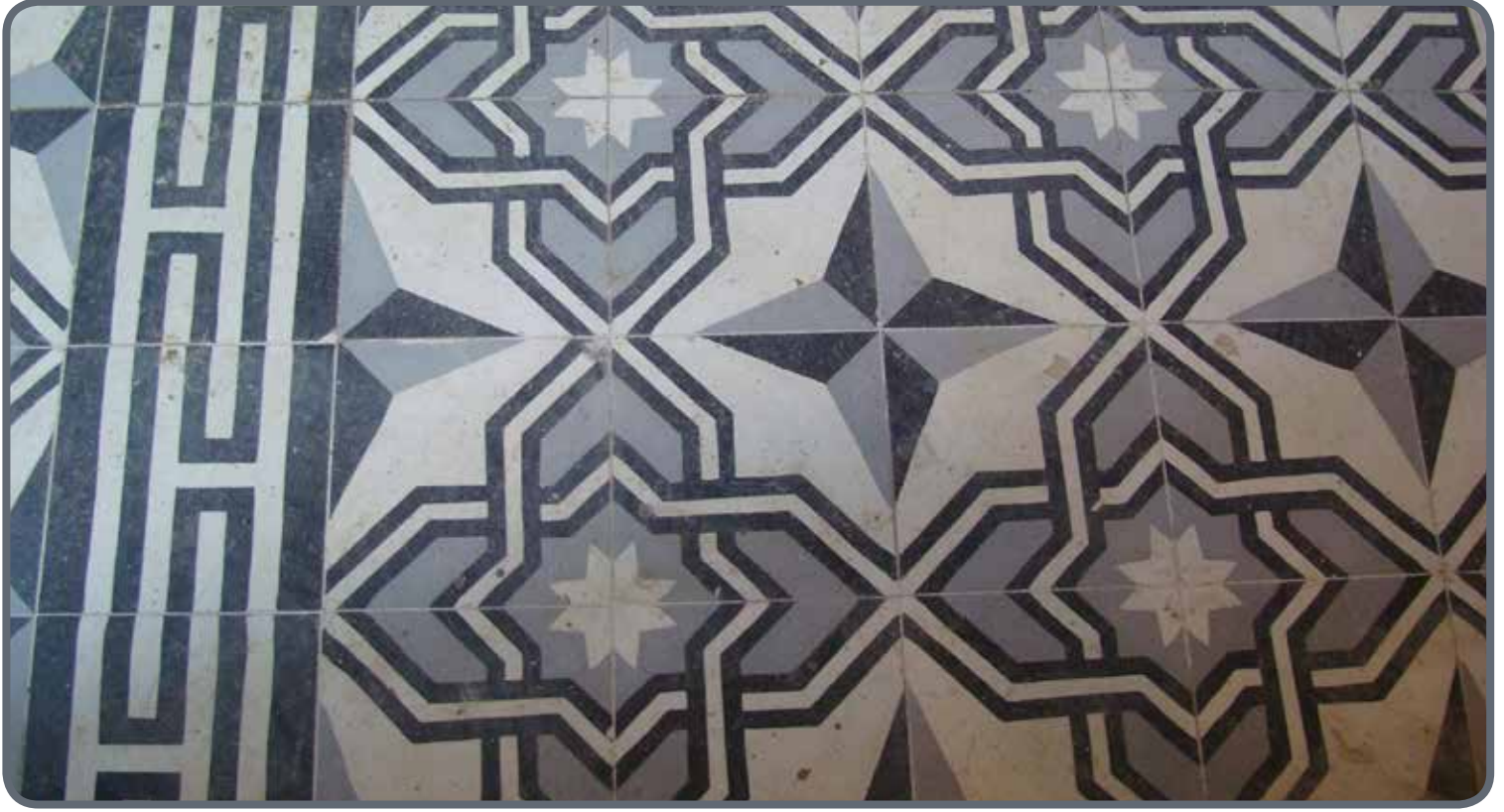
Ek – 29-30-31 : İhale kapsamında uygulama çalışmaları yürütülen 125 Ada 17-66 Parseller - Tes-cilli Kagir Yapı (Eski Fransız Okulu)na ait iç mekan fotoğrafları. (son hali)
