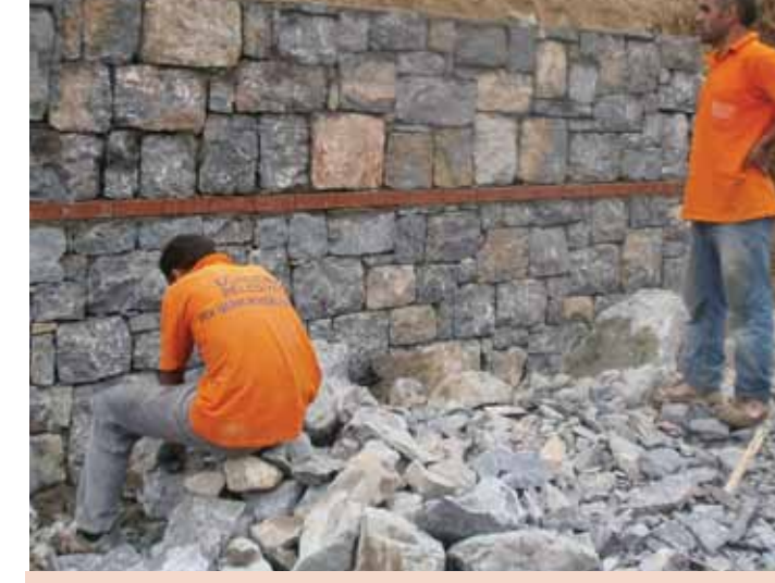
Veysipaşa Sk. duvar yapımı
