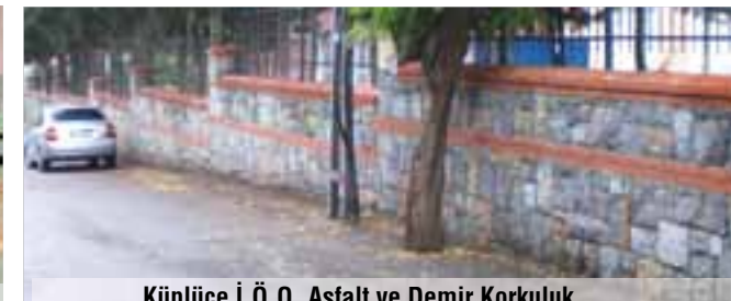
Küplüce İ.Ö.O. Asfalt ve Demir Korkuluk
