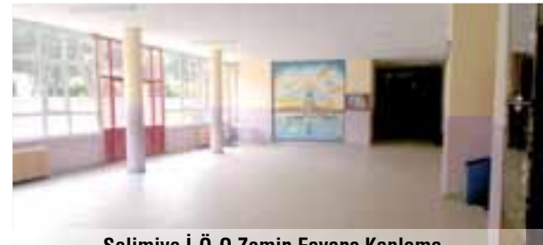
Selimiye İ.Ö.O Zemin Fayans Kaplama
