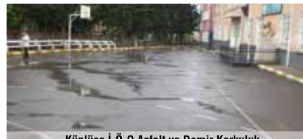
Küplüce İ.Ö.O Asfalt ve Demir Korkuluk
