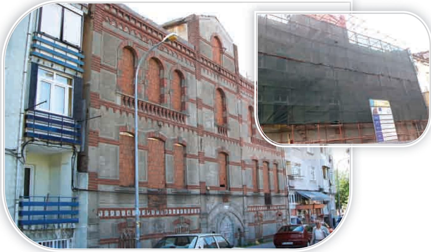
Ek - 29: İhale kapsamında uygulama çalışmalarına başlanılan 125 Ada 17-66 Parseller - Tescilli Kagir Yapı (Eski Fransız Okulu)na ait fotoğraflar. (uygulama sırasında)
