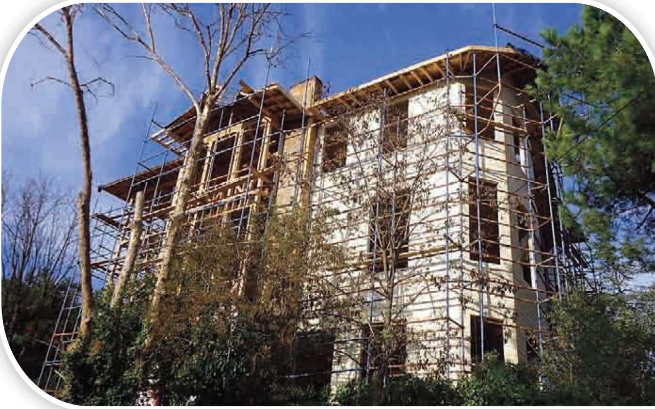
Ek - 24: İhale kapsamında uygulama çalışmalarına başlanılan 1812 ada 101 parsel Burhan Felek Bey Köşkü'ne ait fotoğraflar . (restorasyon devam etmektedir)
