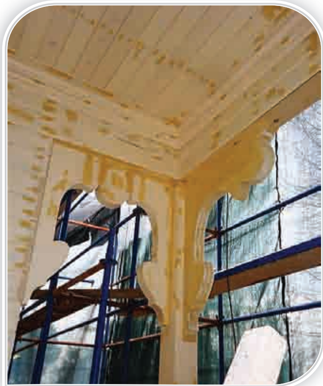
Ek - 25-26: İhale kapsamında uygulama çalışmalarına başlanılan 1812 ada 101 parsel Burhan Felek Bey Köşkü'nün restorasyon çalışmasına ait ahşap detay fotoğrafları .
