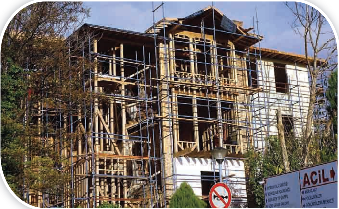
Ek - 23: İhale kapsamında uygulama çalışmalarına başlanılan 1812 ada 101 parsel Burhan Felek Bey Köşkü'ne ait fotoğraflar (restorasyon devam etmektedir)
