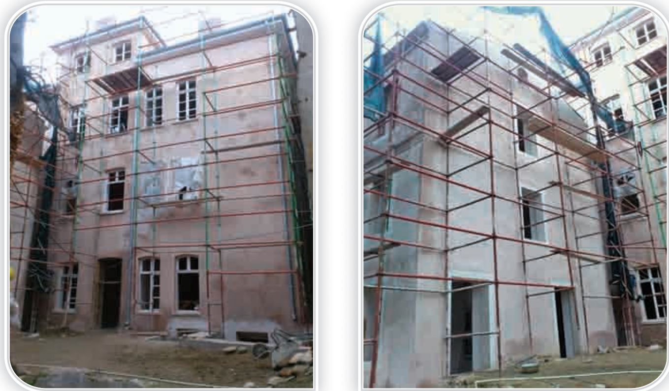
Ek - 30-31: İhale kapsamında uygulama çalışmalarına başlanılan 125 Ada 17-66 Parseller - Tescilli Kagir Yapı (Eski Fransız Okulu)na ait fotoğraflar. (uygulama sırasında)
