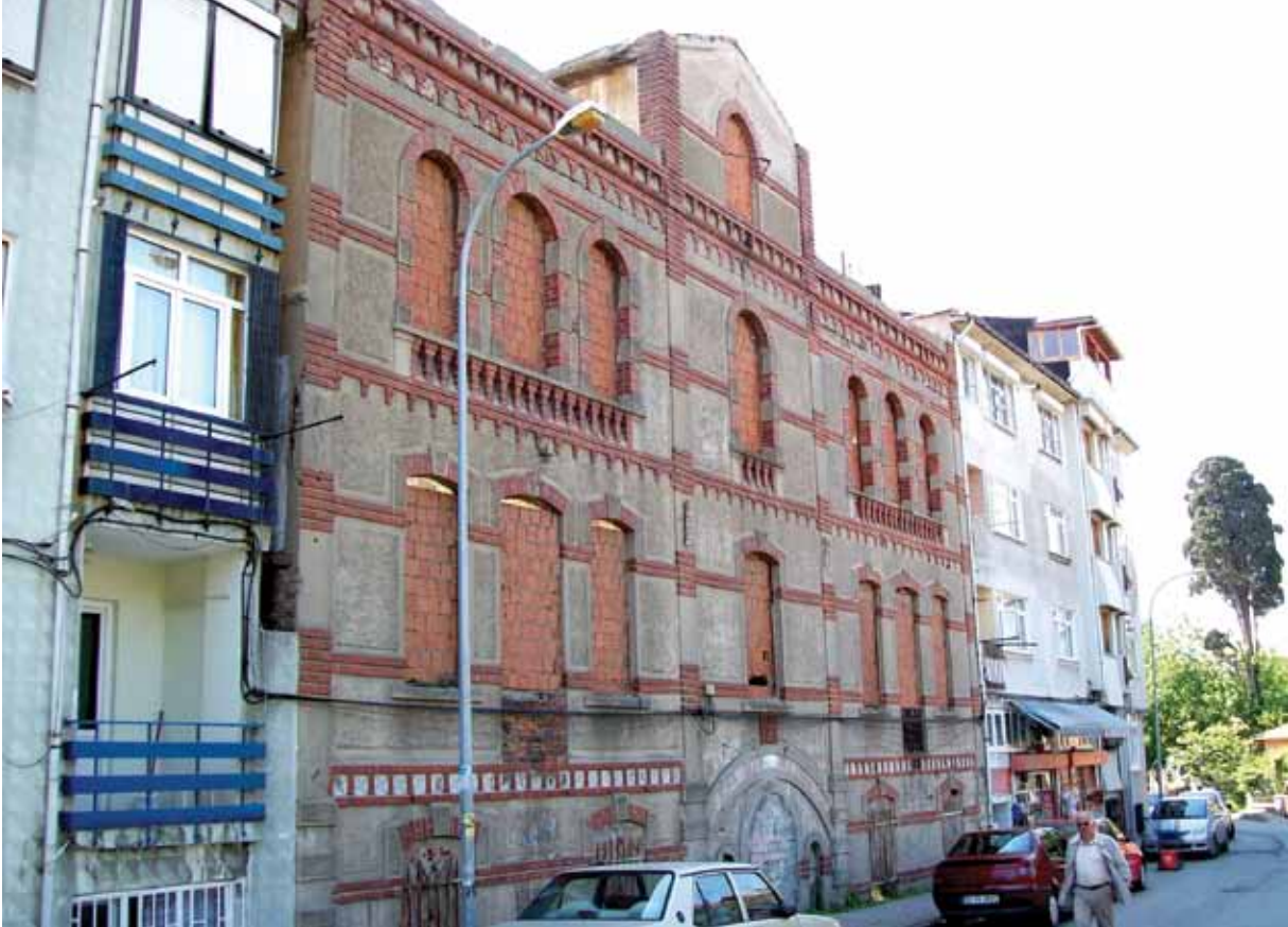
İhale kapsamında uygulama çalışmalarına başlanılan 125 Ada 17-66 Parseller - Tescilli Kağır Yapı (Eski Fransız Okulu)na ait fotoğraflar. (uygulama öncesi)
