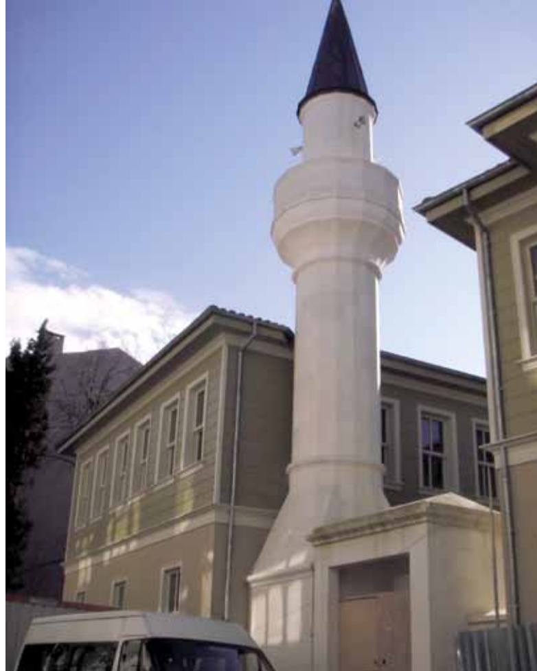
İhale kapsamında uygulama çalışmalarına başlanılan 266 Ada 38 Parseldeki (E:7-8 parseller) Nalçacı Dergahı'nın tamamlanan uygulamasına ait fotoğraflar.(uygulama sonrası)
