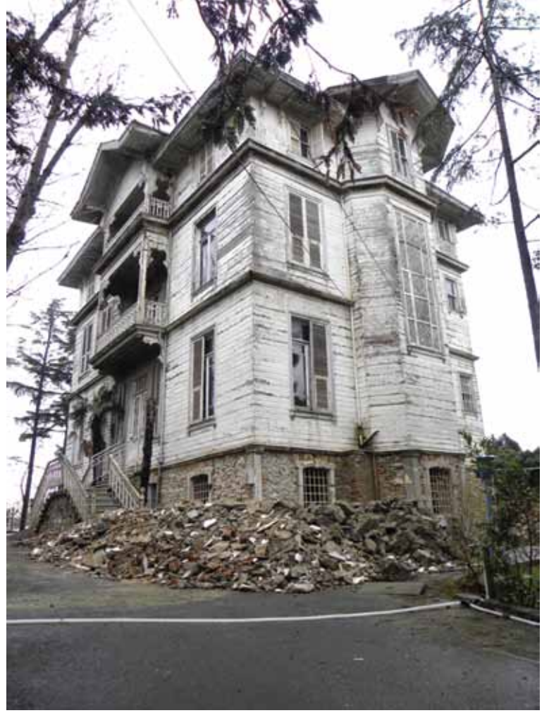
İhale kapsamında uygulama çalışmalarına başlanılan 1812 ada 101 parsel Burhan Felek Bey Köşkü'ne ait fotoğraflar (uygulama devam ediyor)
