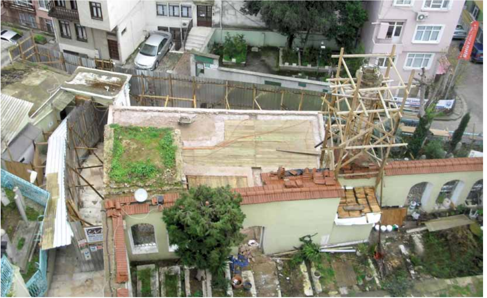
İhale kapsamında uygulama çalışmalarına başlanılan 443 ada 23-24 parseller - Aziz Mahmut Hüdai Külliyesi İçinde Yer Alan Cümle Kapısı - Meşrutalar - Çeşmelerine ait fotoğraflar (meşruta 2 - çeşmeler- cümle kapısı uygulama sonrası)
