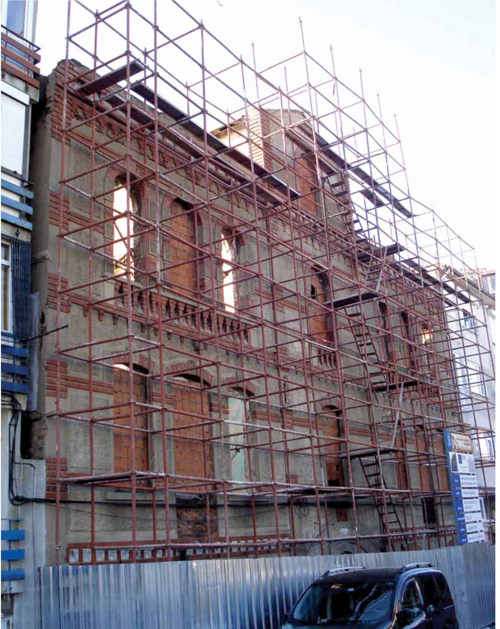
İhale kapsamında uygulama çalışmalarına başlanılan 125 Ada 17-66 Parseller - Tescilli Kağır Yapı (Eski Fransız Okulu)na ait fotoğraflar. (uygulama sırasında)
