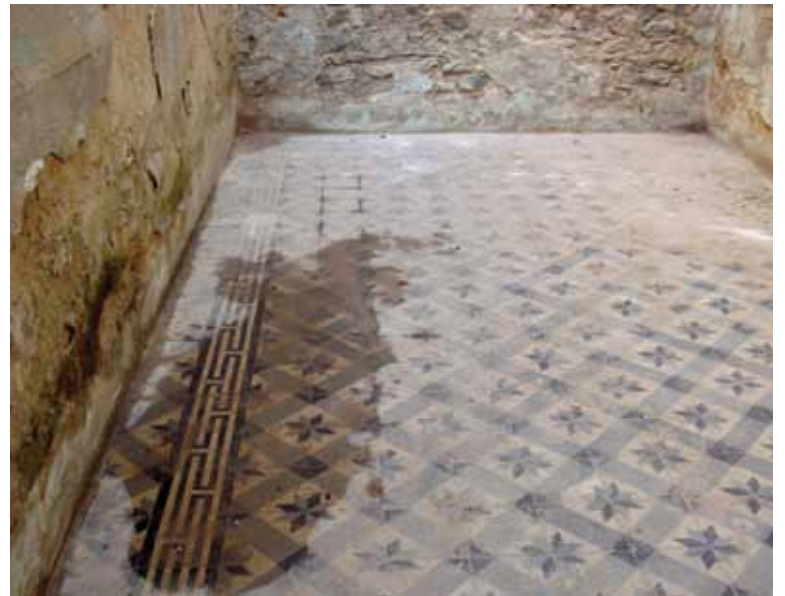
İhale kapsamında uygulama çalışmalarına başlanılan 125 Ada 17-66 Parseller - Tescilli Kağır Yapının (Eski Fransız Okulu) fotoğrafları. (Karo siman döşeme kaplaması, uygulama sırasında)
