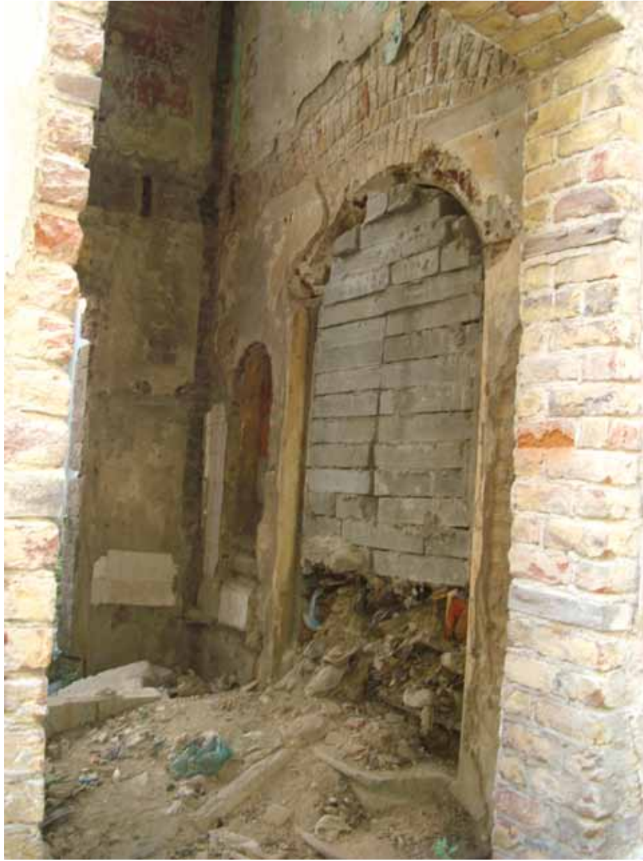
İhale kapsamında uygulama çalışmalarına başlanılan 125 Ada 17-66 Parseller - Tescilli Kağır Yapının (Eski Fransız Okulu) fotoğrafları. (Yeni Dershane Sokağı'na bakan cephesindeki kapı açıklığı, uygulama öncesinde)
