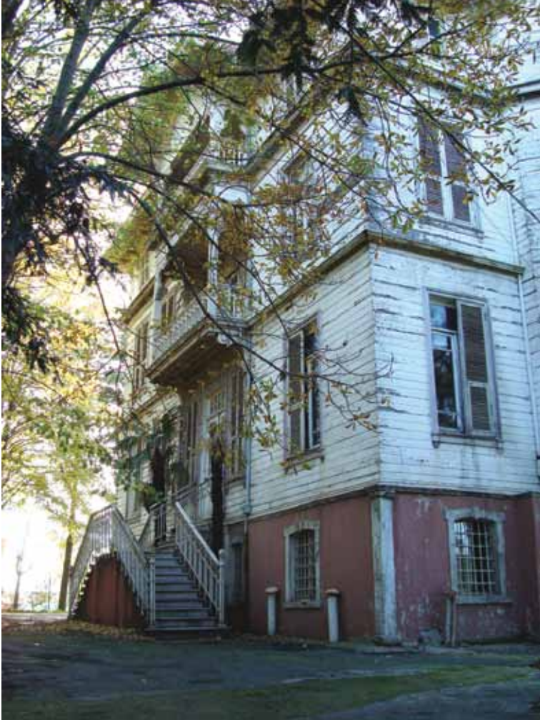
İhale kapsamında uygulama çalışmalarına başlanılan 1812 ada 101 parsel Burhan Felek Bey Köşkü'ne ait fotoğraflar (uygulama öncesi)
