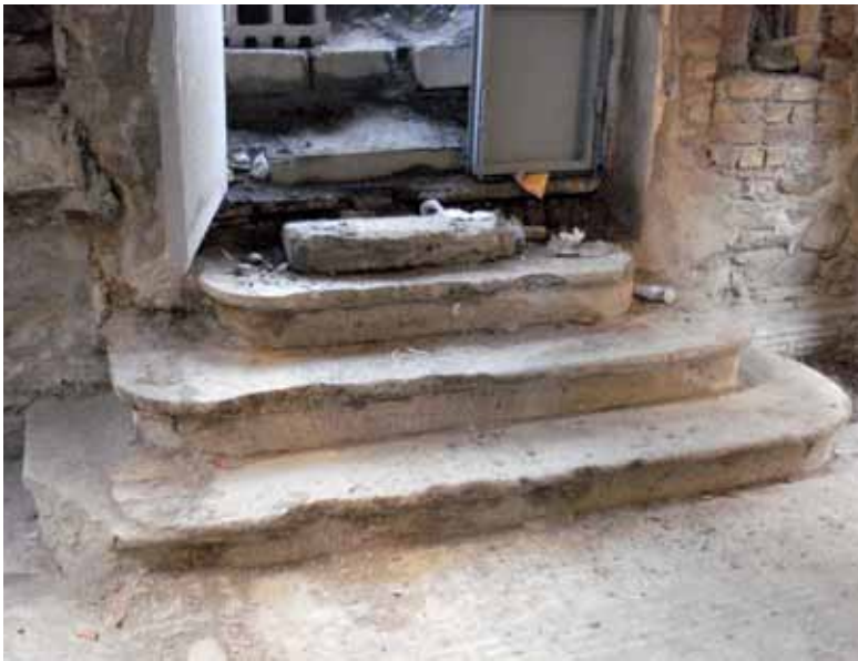
İhale kapsamında uygulama çalışmalarına başlanılan 125 Ada 17-66 Parseller - Tescilli Kağır Yapının (Eski Fransız Okulu) fotoğrafları. (Yeni Dershane Sokağı'na bakan cephesindeki kapı açıklığı, uygulama sırasında)
