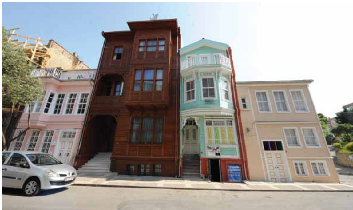
İcadiye Mahallesi, Cemil Meriç Sokak'ta basit onarım kapsamında yürütülen çalışmalardan örnek (öncesi ve sonrası)
