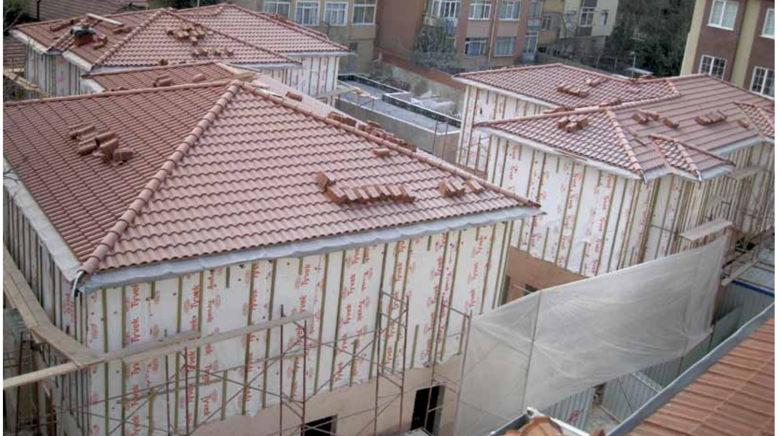
İhale kapsamında uygulama çalışmalarına başlanılan 266 Ada 38 Parsel (E:7-8 parseller)deki Nalçacı Dergahı'nın uygulamasına ait fotoğraflar. (uygulama sırasında)
