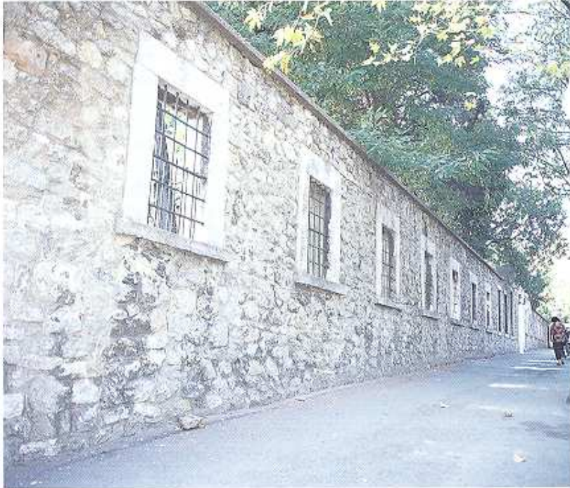
> Çiçekçi Camii'nin Dış Avlu Duvarı
