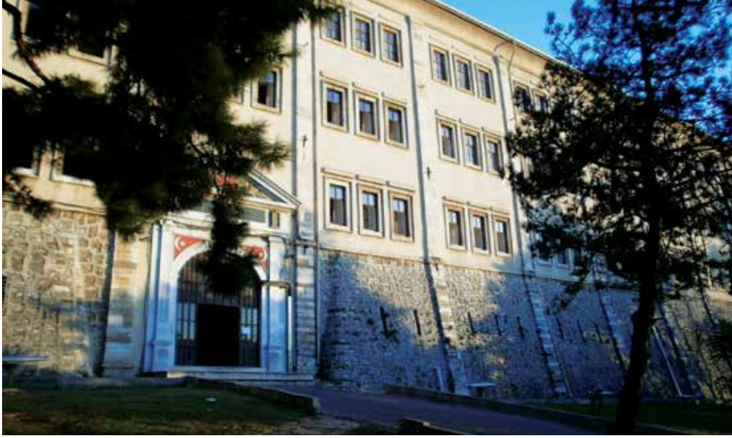
Selimiye Kışlası batı cephe giriş kapısı
