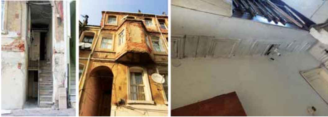
Şekil 10: Sıra evlerdeki niteliksiz müdahaleler (İTÜ Restorasyon Birimi Arşivi)
