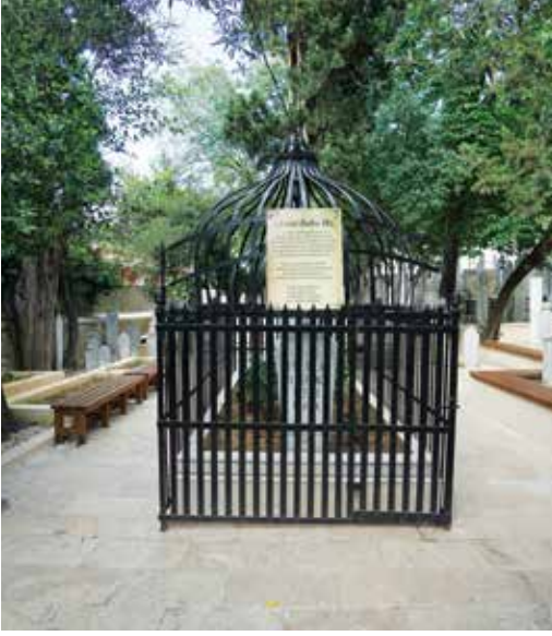
Selami Ali Açık Türbesi restorasyon sonrası durumu (sol), Kaptanıderya mezar taşı (sağ)
