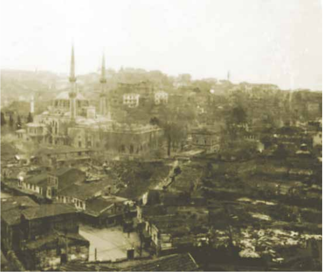
Mihrimah Sultan Camii'nin minaresinden Gülnuş Emetullah Sultan Külliyesi'ne bakış, Encümen Arşivi
