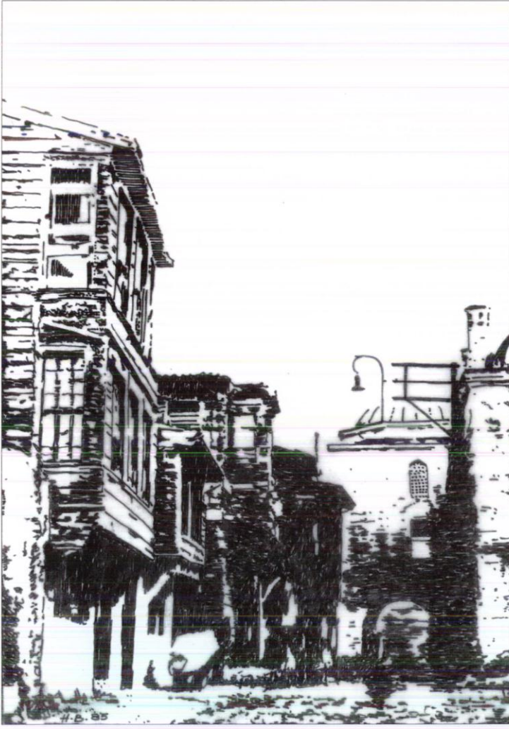
Valide Kahyası Sokak ve Valide-i Atik Camii
