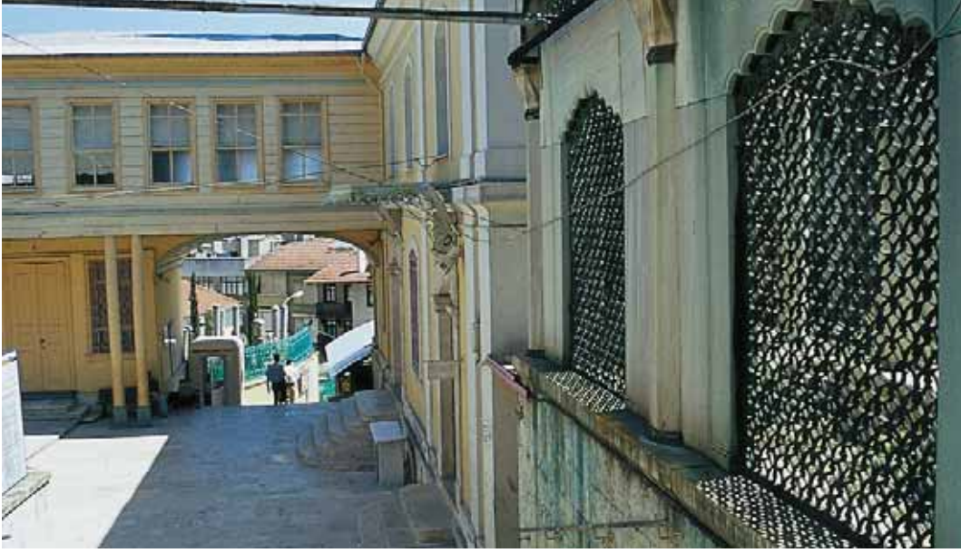
Üst bahçe kapısından Camii girişi ve Hünkar Mahfili
