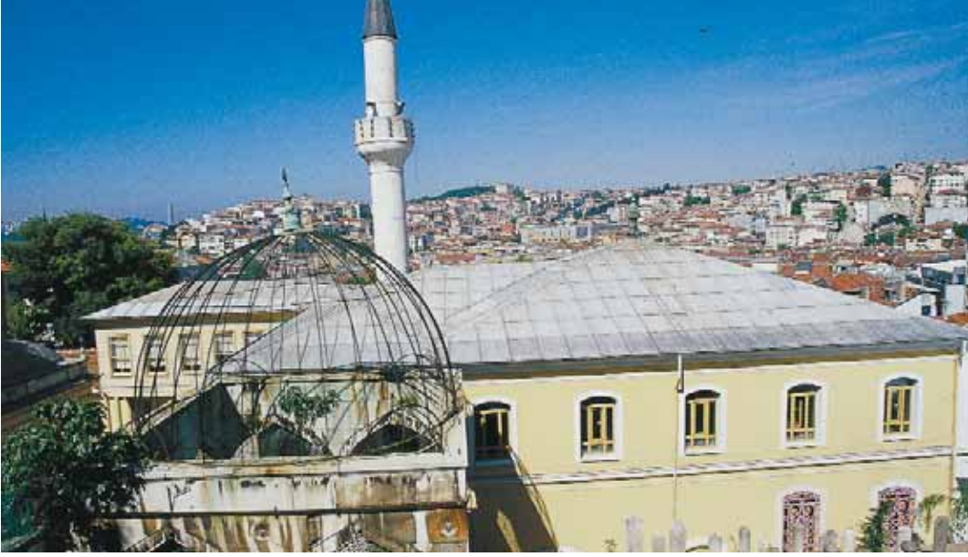
Külliye'nin dış görünüşü
