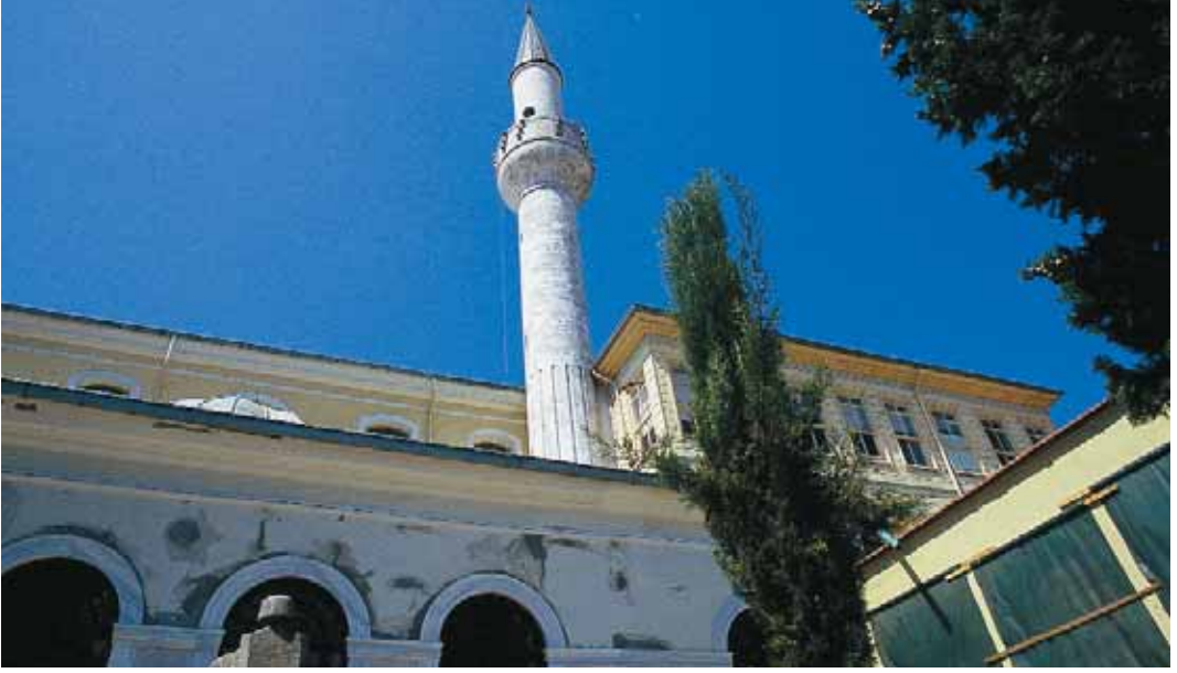
Azîz Mahmud Hüdâyî Külliyesi alt girişten görünüşü
