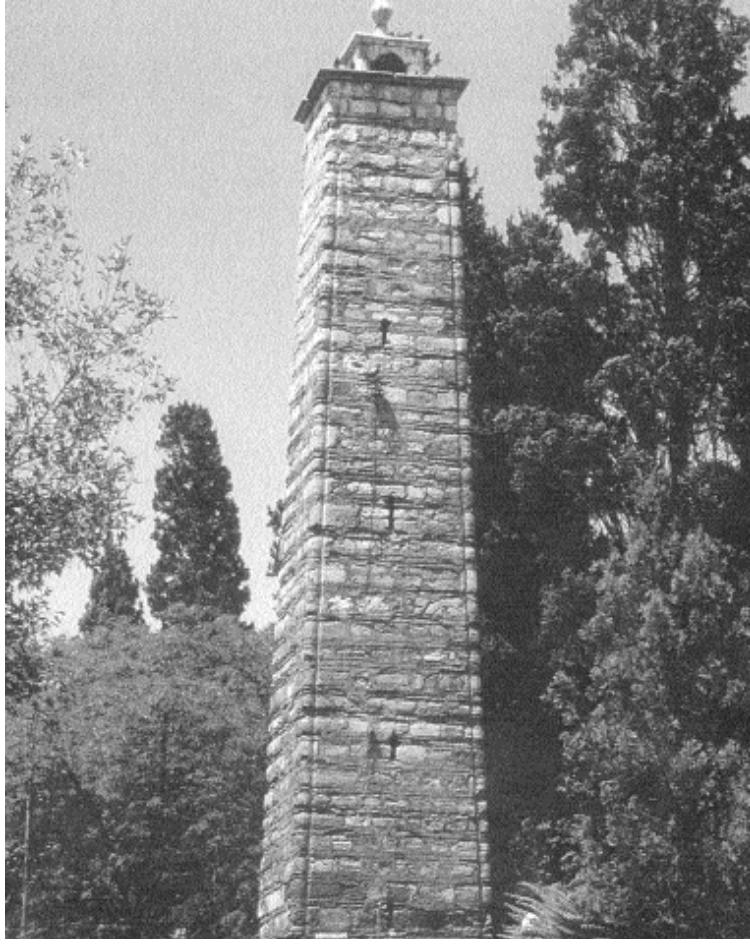
Üsküdar Duvardibi seminde bir su terazisi (yapımında kullanılan taş ve işçiliği dikkat çekicidir)
