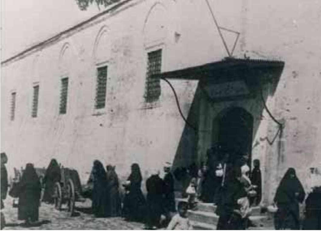
Üsküdar'daki Hilâl-i Ahmer Aşhanesinin bulunduğu Atik Valide Camii'nin avlusuna girilen kuzey kapısı ( İ.Ü. Cerrahpaşa Tıp Fakültesi Tıp Tarihi Müzesi Arşivi)
