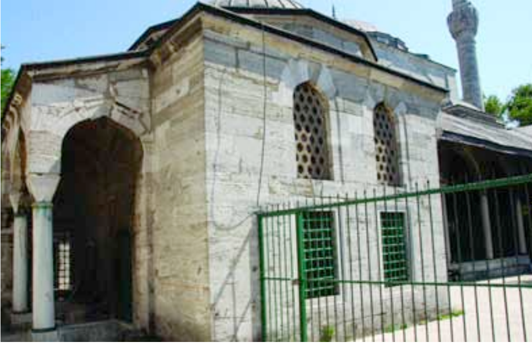
Sinaneddin Yusuf Paşa türbesinin kuzey cephe görünüşü
