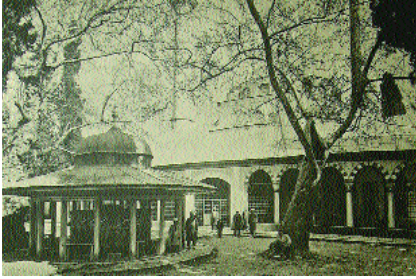
Foto 12: Eski Camii (Atik Valide Sultan Camii) şadırvanı
