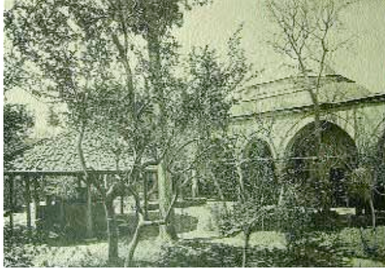
Foto 11: Eski Camii (Atik Valide Sultan Külliyesi) medrese avlusu
