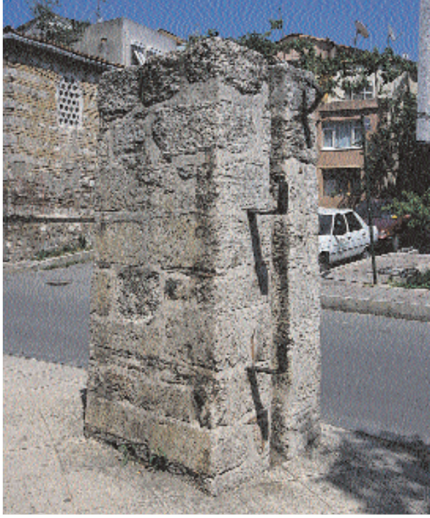
Resim:3. Damad İbrahim Paşa Suyolu'na Bağlı Doğuncılar'daki Terazi.
