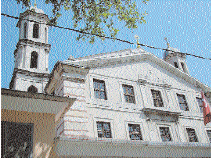
Surp Garabed Kilisesi - Batı Cephesi
