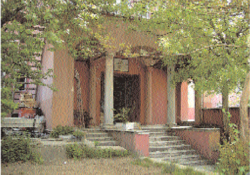
Surp Haç Okulu'nun tarihi binası - Giriş cephesi
