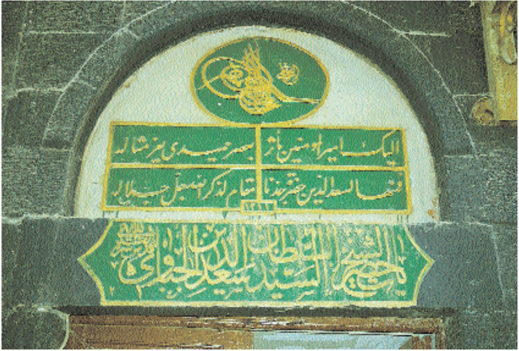
2. Cibavî Zaviyesi'nde Osmanlı onarım kitabesi.
