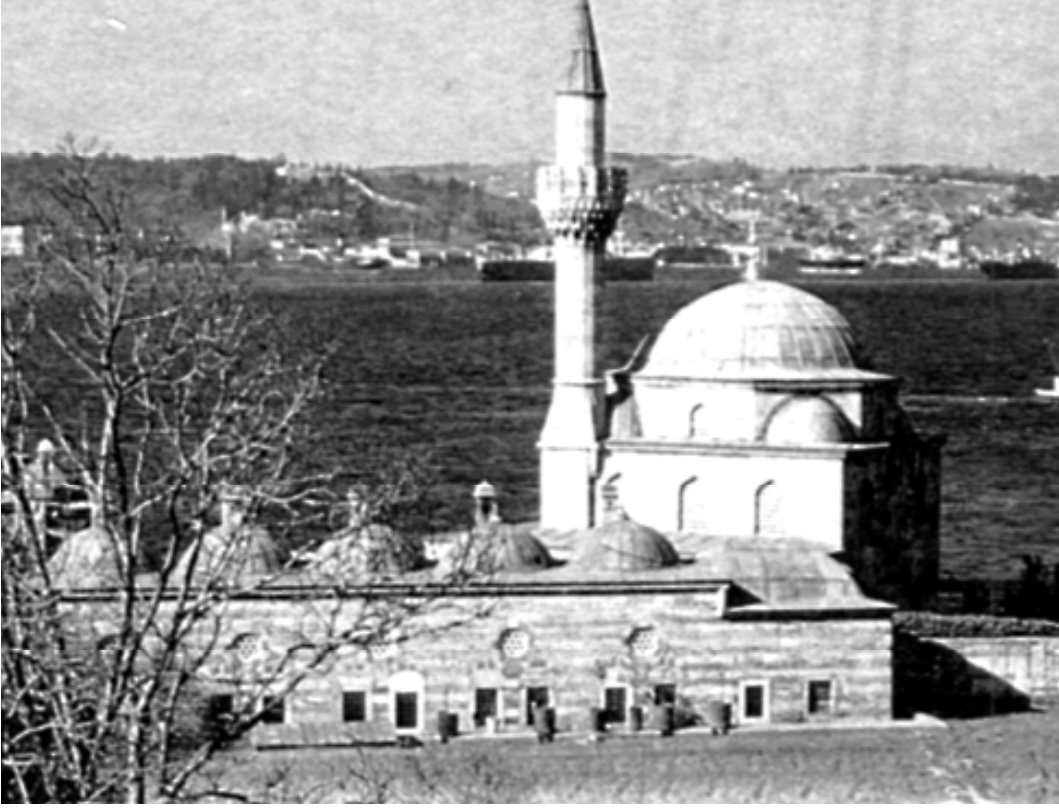
Şekil 8: Caminin kuzey ve batı cephesini saran revak (eski hâli)
