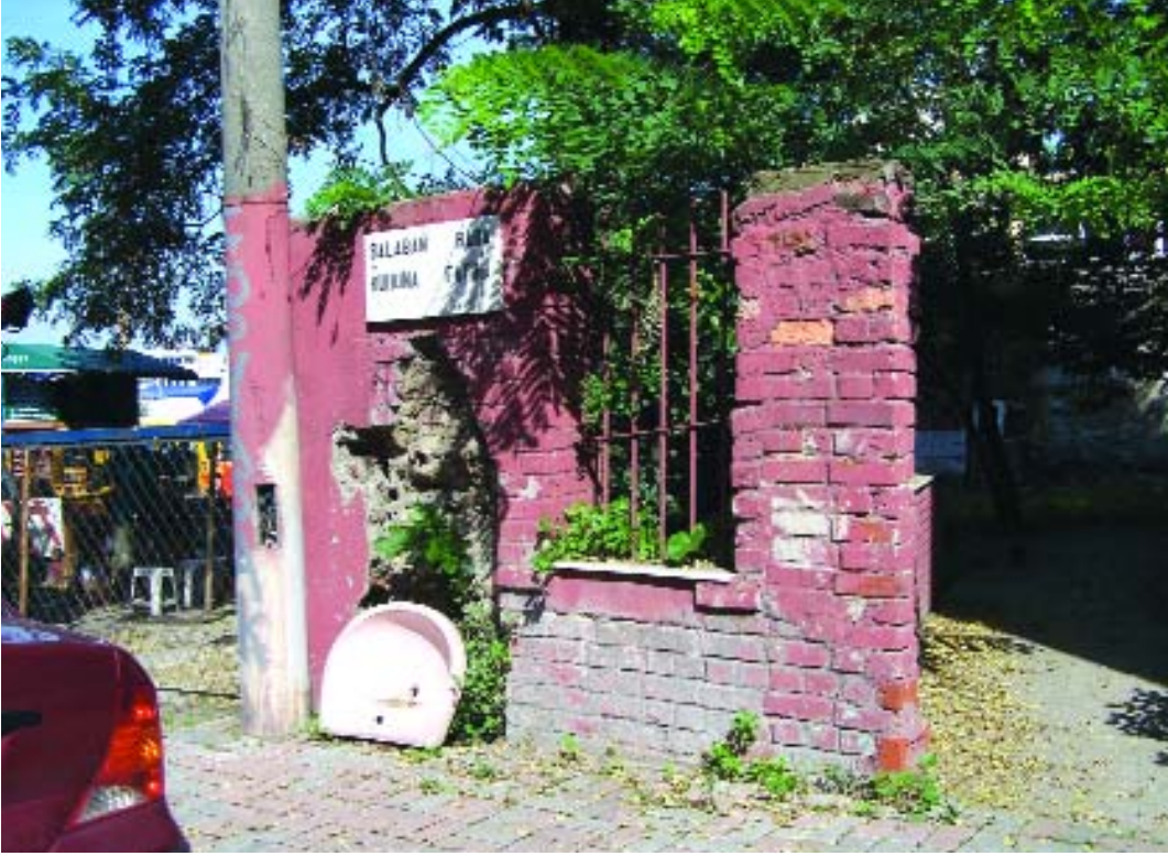
R 12- Balaban Dergahı çeşme duvarı kalıntısı
