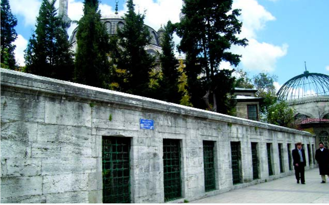
Yeni Valide Camii Haziresi'nin yoldan görünümü
