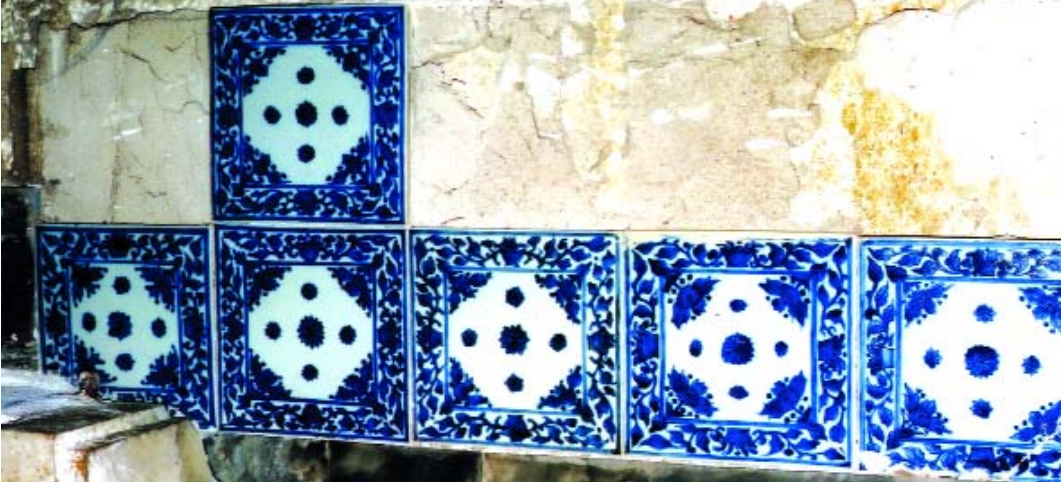
Ayazma Camii'nden çalınan çinilerden boş kalan yerler
