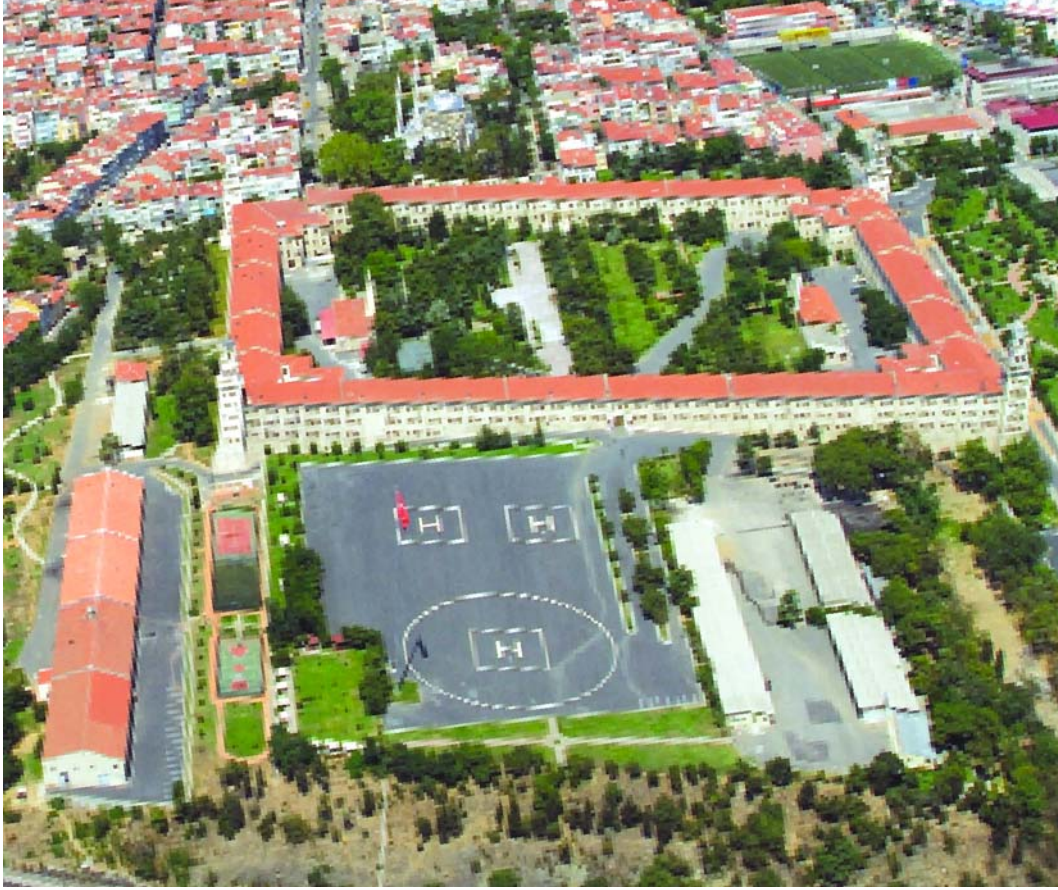
Selimiye Kışlası'nın havadan görünümü
